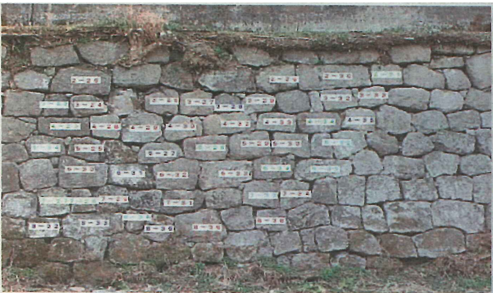
石垣の照合に関する検証資料。左写真のように復旧するため、石を一つ一つ撮影し、大きさや形などからどこに積まれていたのかをコンピューターが解析する
